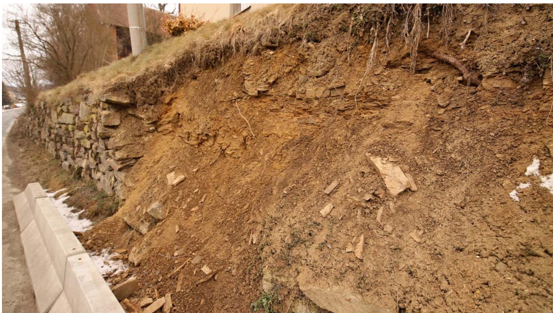
Obrázek 7: detail stavu zvětrání masivu rul a mocnosti zdi v místě havárie
