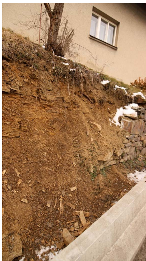
Obrázek 8: detail místa havárie zdi
