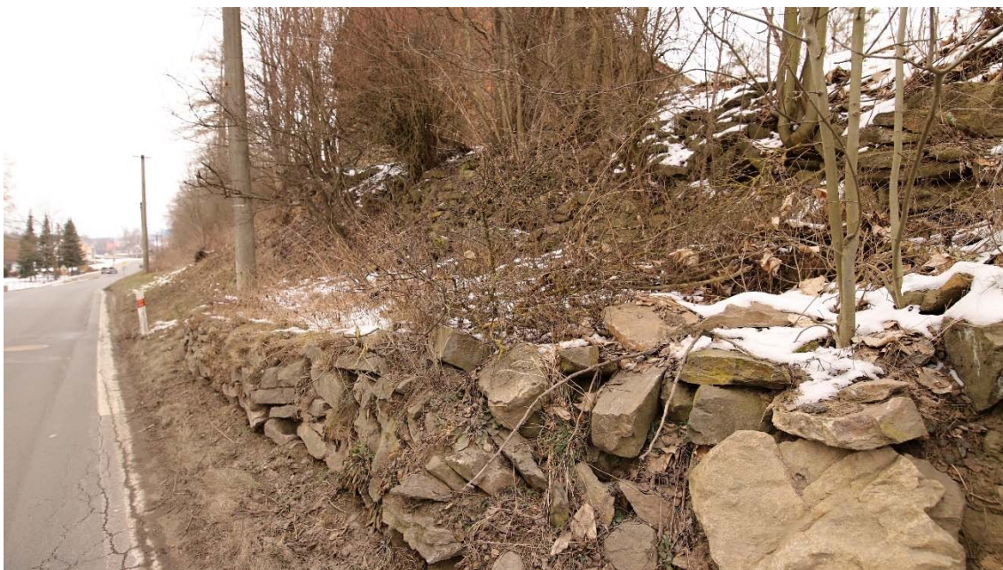
Obrázek 2: stav zdi a navazujícího svahu s původnímu zídkami na pozemku parc. č. 97 a 390/2, stávající zeď je v podstatě zcela rozpadlá a velmi narušená.
