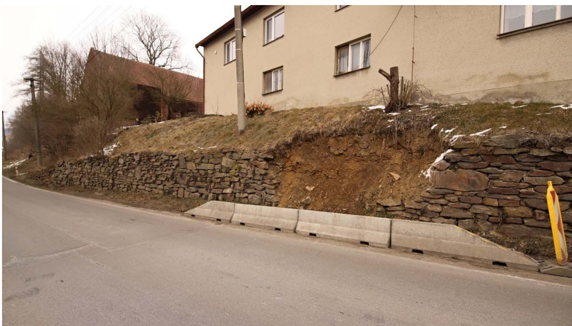
Obrázek 6: celkový pohled na místo havárie zdi a svahu a vazbu na rodinný dům č.p. 15, sloup NN je založen v narušených a oslabených poměrech
