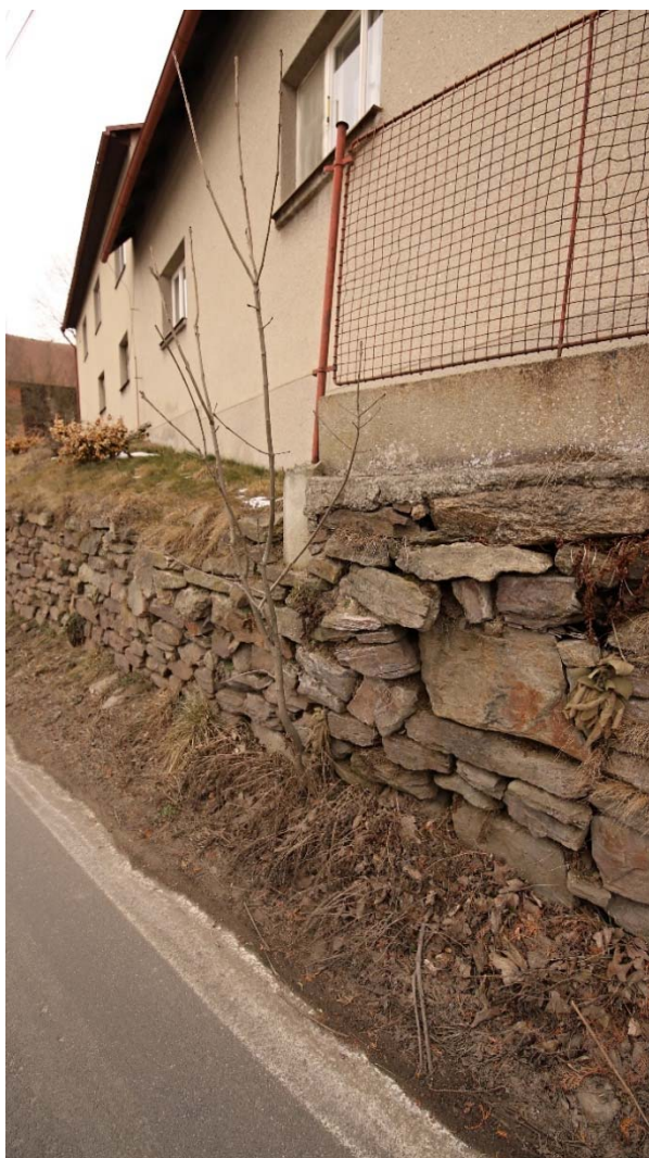
Obrázek 12: detail stavu narušení zdi z rohu domu č.p. 15 s konstrukcí plotu na horní hraně zdi
