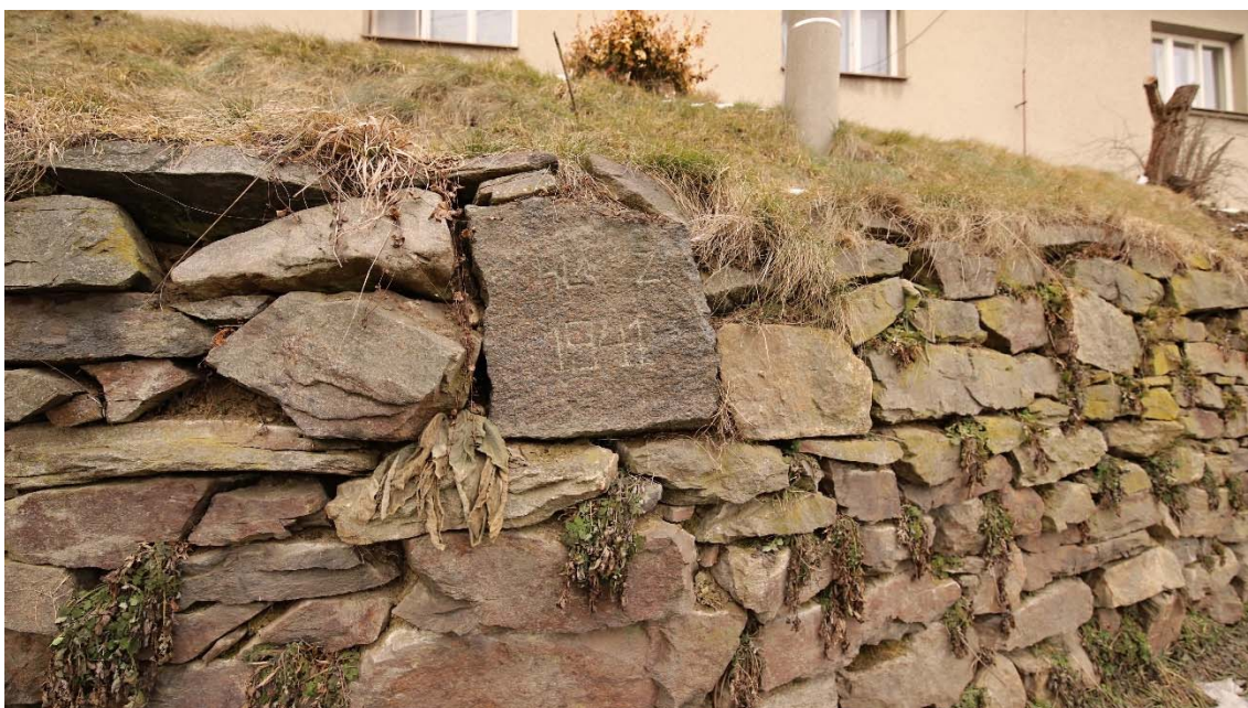
Obrázek 4: detail stávající zdi na pomezí pozemku parc. č. 390/2 a 736, různorodé kameny zdiva, bez pojiva, hustě prorostlé vegetací
