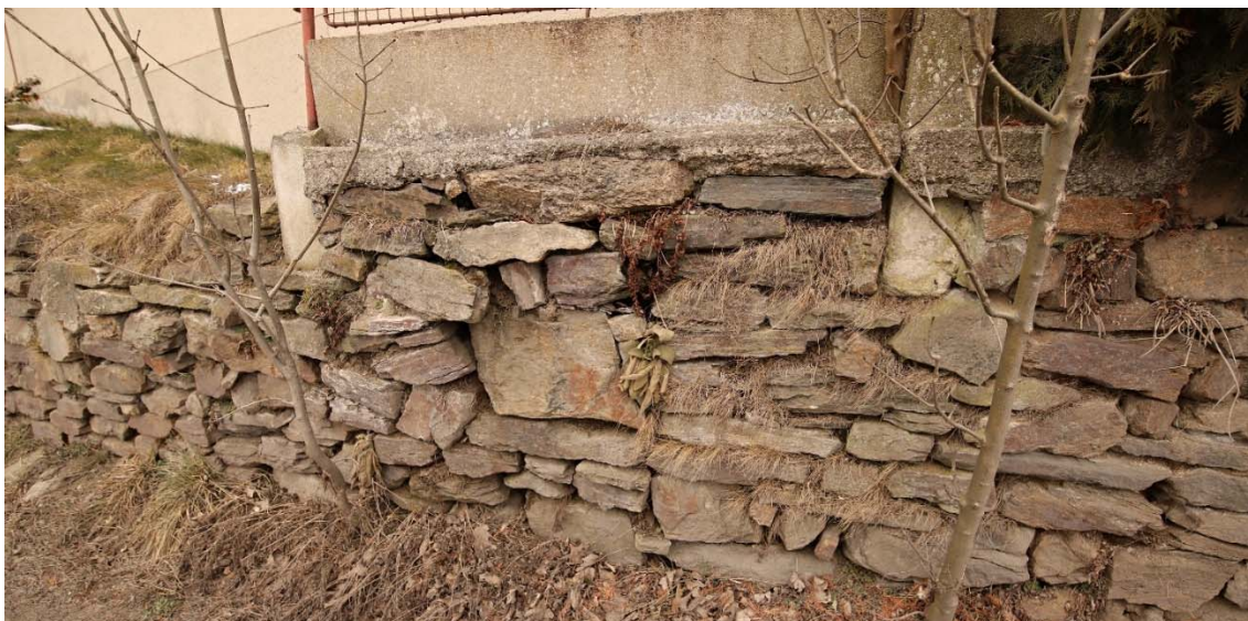
Obrázek 11: detail místa, kde stávající zídka je přímo navázána na základové konstrukce rodinného domu č.p. 15
