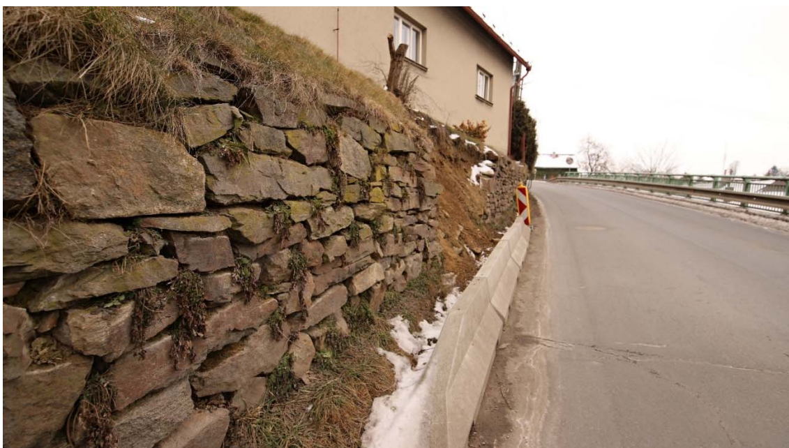
Obrázek 5: stav zdi v místě havárie s instalovanou ochranou betonovou vodící zídskou výšky 0,45 m, značné boulení zdi
