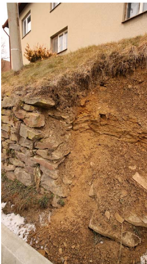
Obrázek 7: detail stavu zvětrání masivu rul a mocnosti zdi v místě havárie
