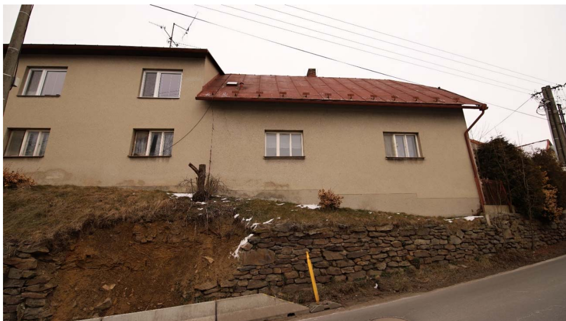
Obrázek 9: pohled na kritický úsek stávající zdi s přímou vazbou na základové poměry RD č.p. 15
